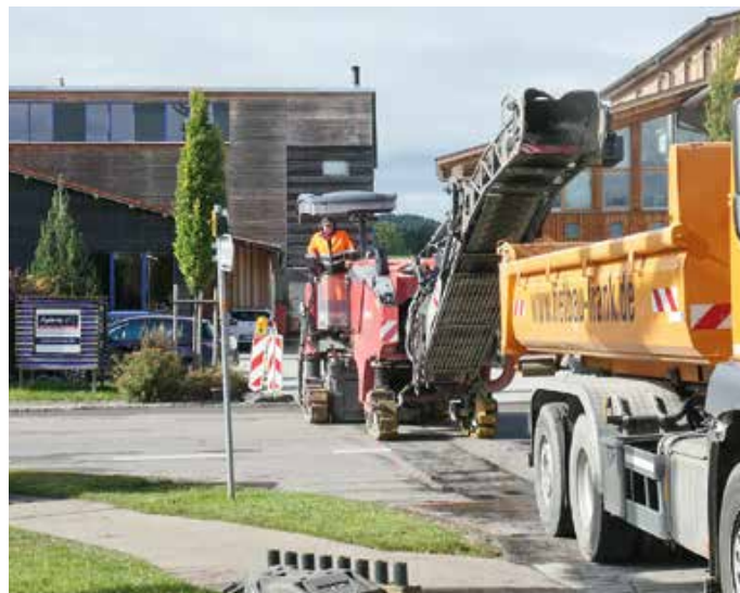
Straßenbauarbeiten Hauptstraße Hopferau. – Foto: Norbert Plattner
