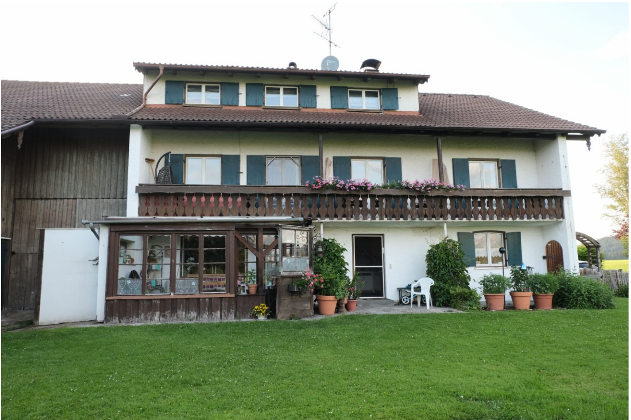
Abbildung 2: Südseite mit Wintergarten. Rechts der Wohnbereich, links ab der Holzverschalung der ehemalige Wirtschaftsteil.
