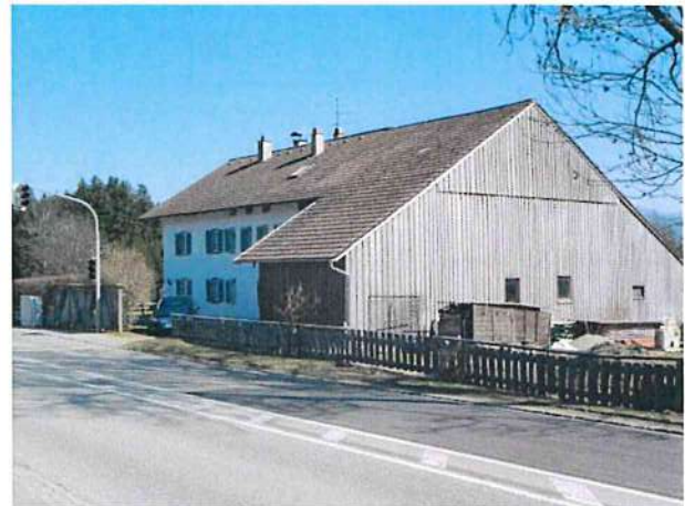
Abb. 11 Blick von Westen – Klare Gebäuderichtung, ineinander übergehende Dachflächen, senkrechte Holzverschalung am Wirtschaftsteil, Fensterläden
