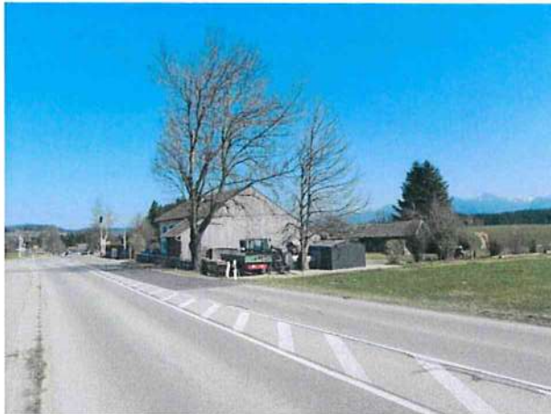
Abb. 10 Blick von Westen auf die ortsbildprägenden Bäume und den Hakenschopf
