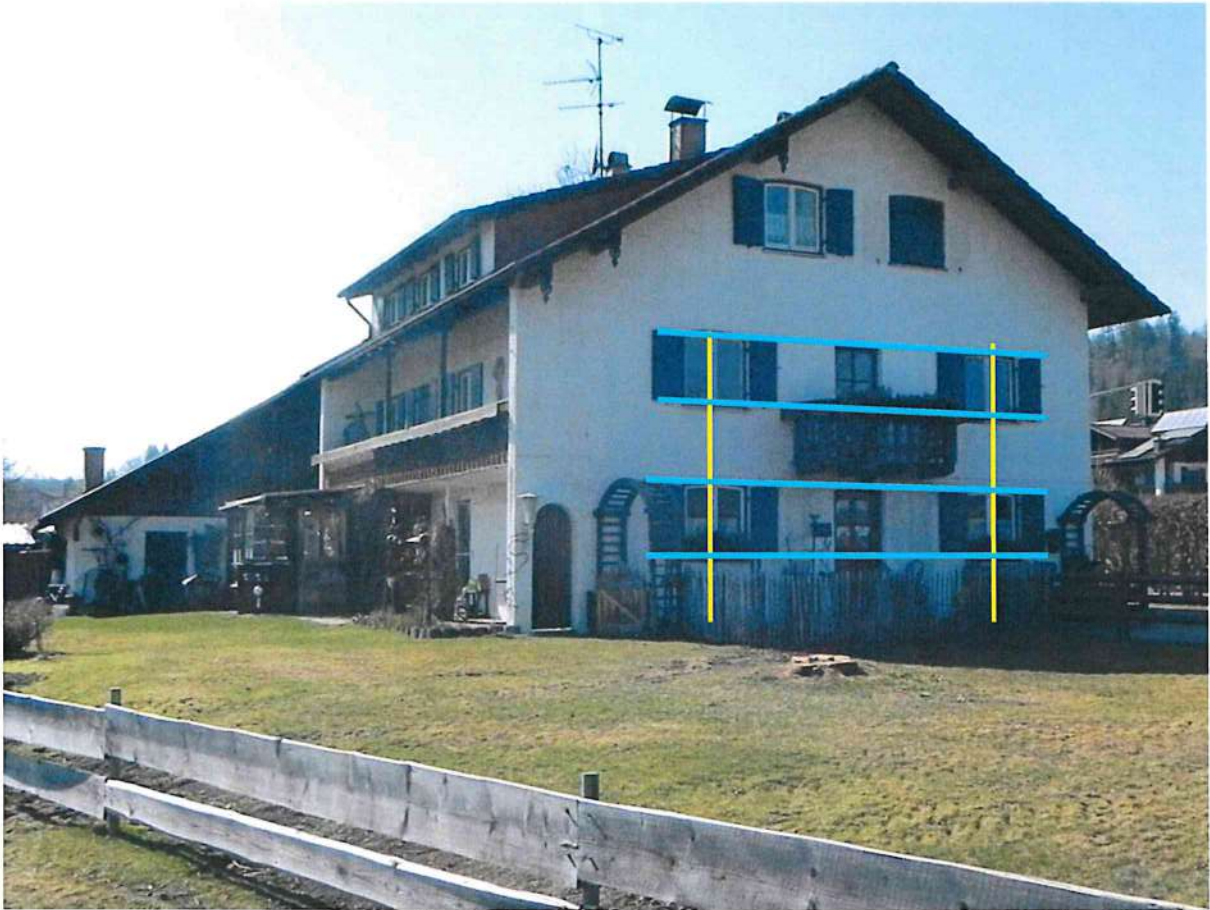
Abb. 12 Verputzte Ostfassade des Bestandes mit im Erdgeschoss und Obergeschoss übereinander liegenden Fenstern und Fenstern (gelbe Linie) und in überwiegend gleicher Höhe je Geschoss (blau)
